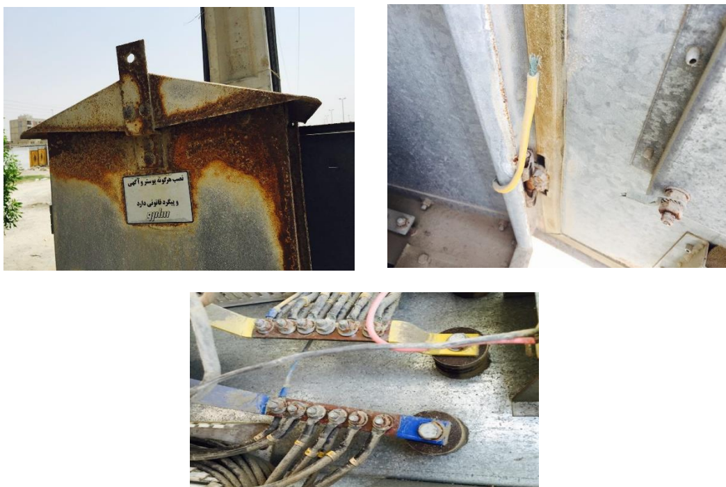
شکل (۲) خوردگی گالوانیکی در تابلوهای برق
